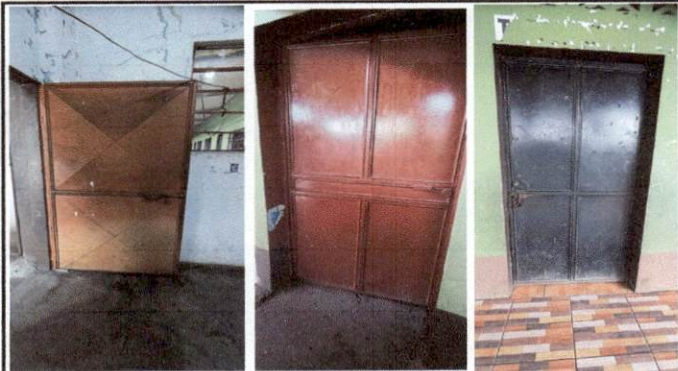
Foto1: Sustitución de puertas
