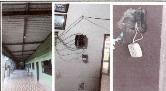
Foto 4: Reparación del sistema eléctrico
