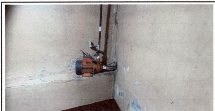
Foto 5: Sustitución de bomba de agua
