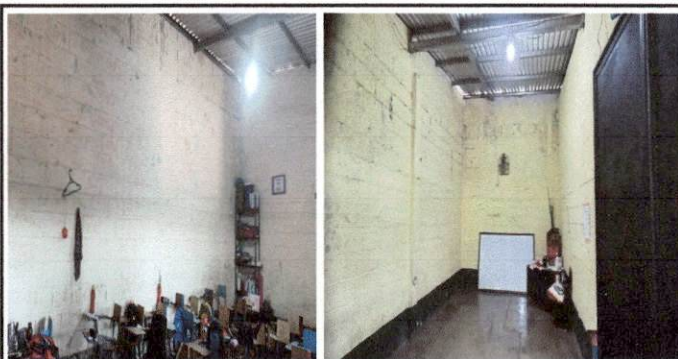
Foto 6: Repello en muro (interiores de los salones)
